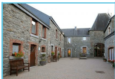
Château-Ferme de Laval
